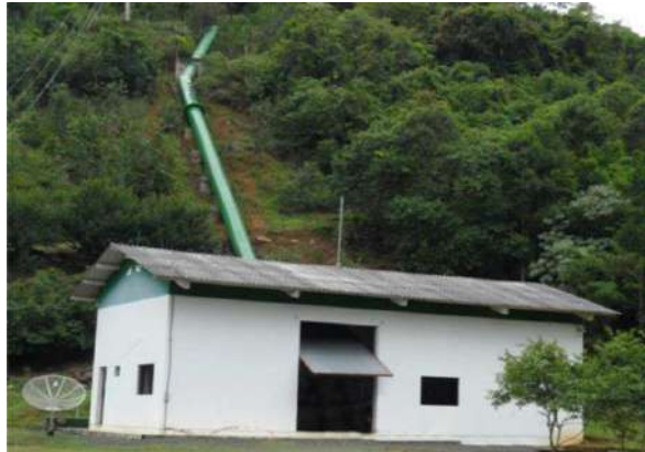
Figura 4 - Casa de força
