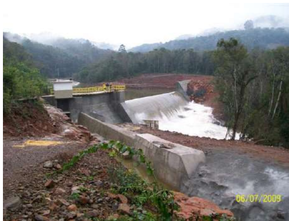
Figura 2 - Barragem e vertedouro
