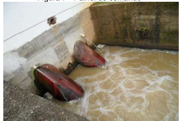
Figura 9 - Canal de fuga
